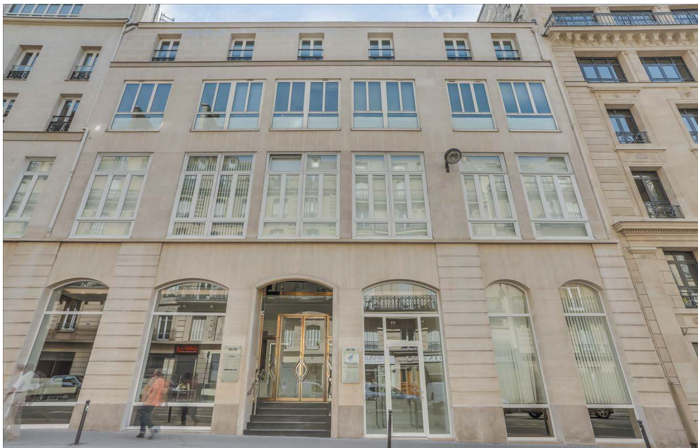
Façade du siège social du 36/38 rue de Saint-Petersbourg - Paris 8 ème
